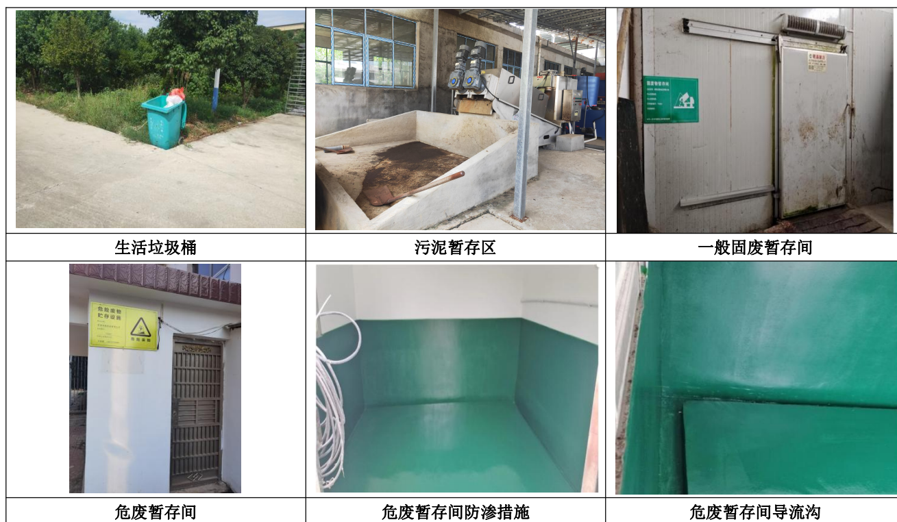
图 4-1-4 项目固废贮存情况图片
