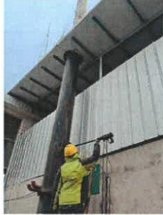
DA002 4T 天然气锅炉 排气筒出口
