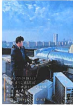
② 有机废气排气筒 (进口)
