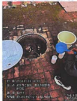
★1 DW001 混合废水排口
